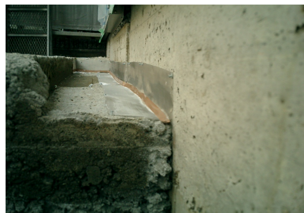
コンクリート打ち継ぎ部分へのメッシュ施工
