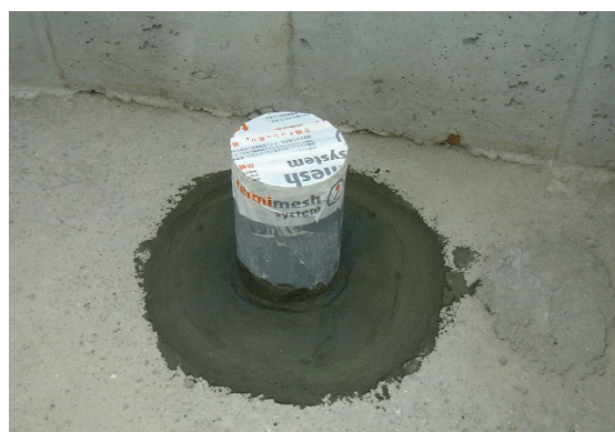
配管部分への接着モルタル施工
