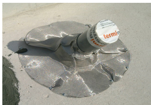
さや管方式の配管へのメッシュ施工
