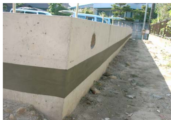
コンクリート打ち継ぎ部分への接着モルタル施工
