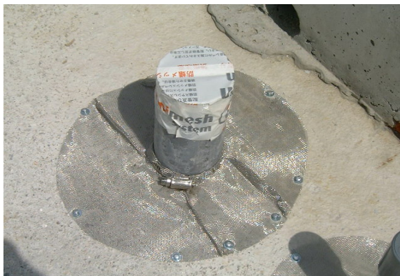
配管部分へのメッシュ施工
