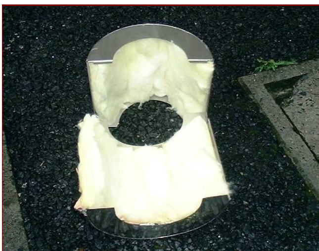
ラッキング材に保温材のグラスウールを詰めます
