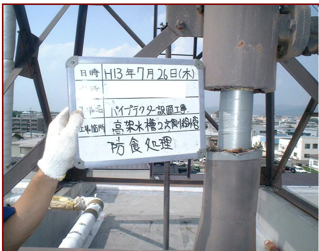
設置部配管を150mm露出させ防蝕テープを巻く
