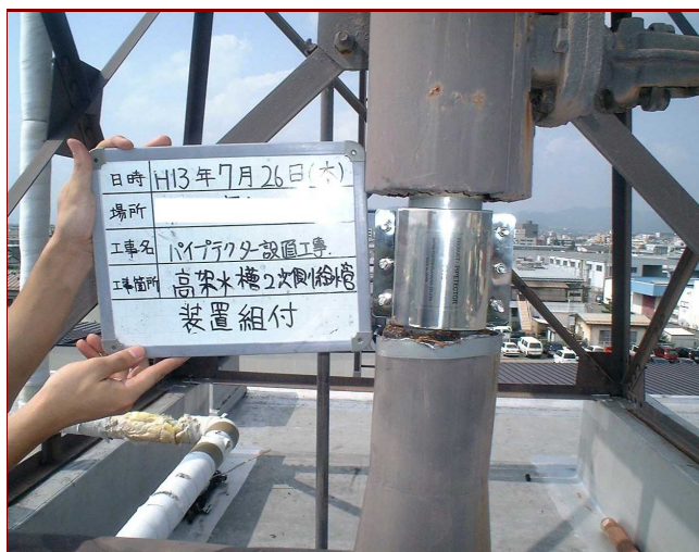
実際のパイプテクター設置はこのようになります
