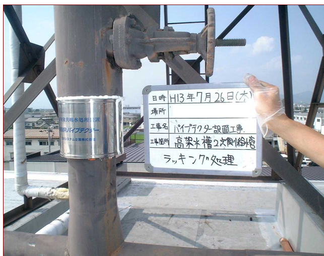
ラッキング材を固定し屋外配管は防水処理する
