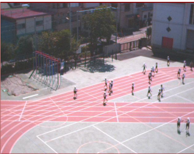
熱交換塗料 施工後1年経過 外気温33.5℃
