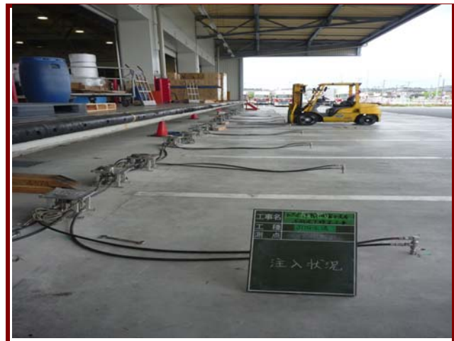
JOG工法注入事例
