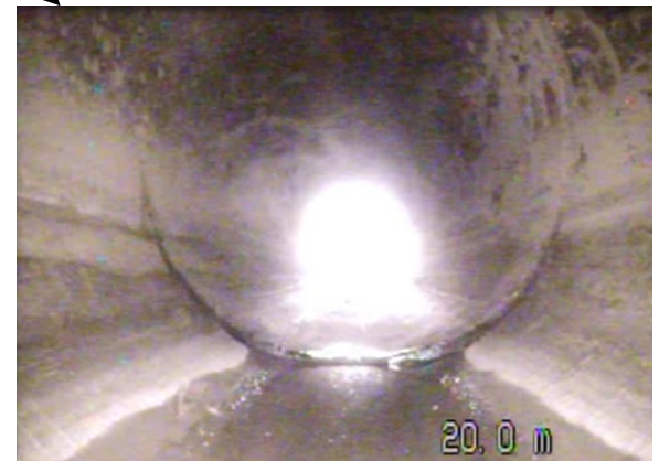
底樋管内状況(上流から20m地点) 16
