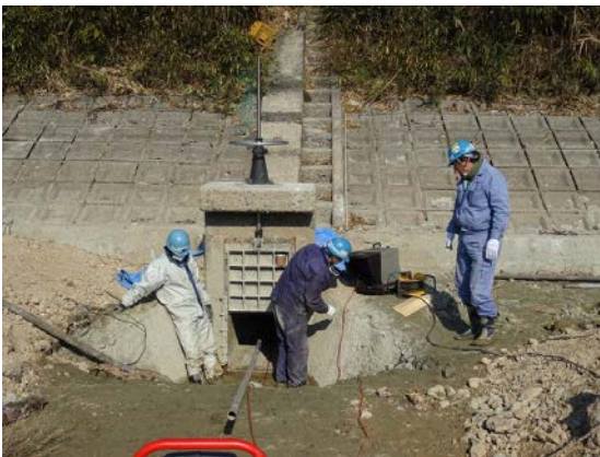
調査状況(上流側)
