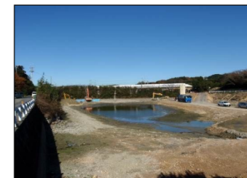
【工事中の状況】
