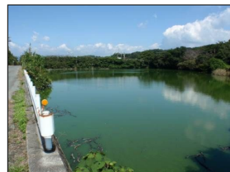
【工事前の状況】
