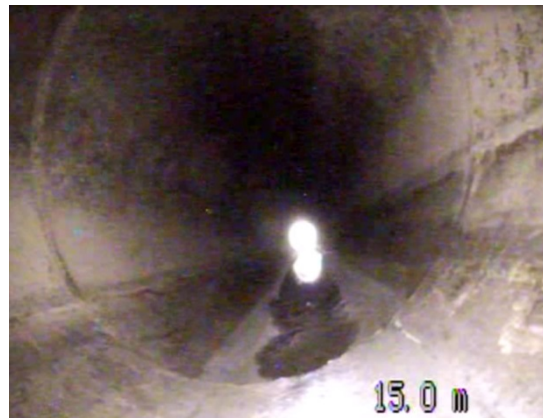
底樋管内状況(上流から15m地点)
