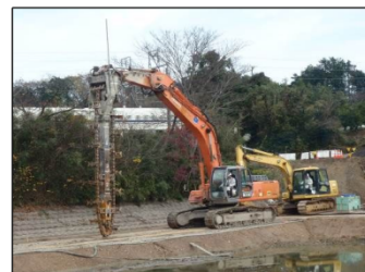
【地盤改良機械(パワーブレンダー)】
