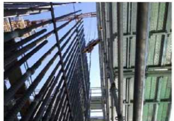
タワー型クレーンフック状況(再現)
