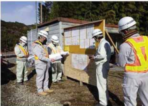
安全パトロールの施状況
