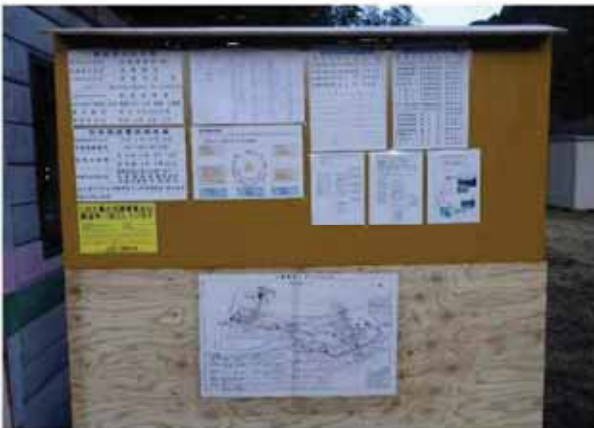
現場事務所隣のハザードマップを更新
