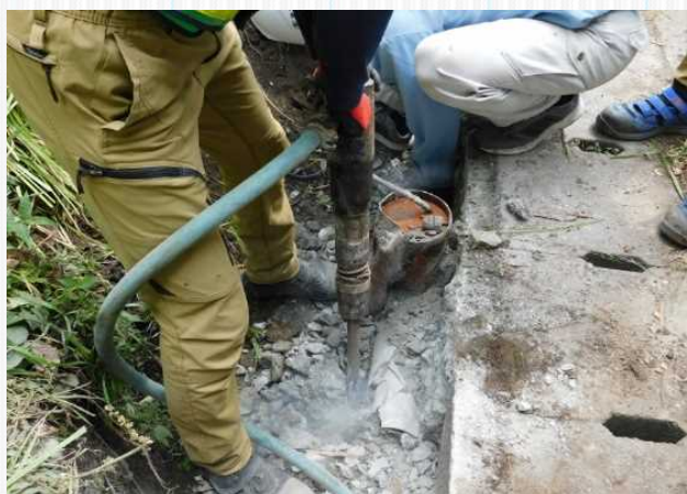
人力取壊し作業状況
