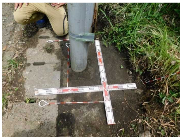
基礎上部状況確認
