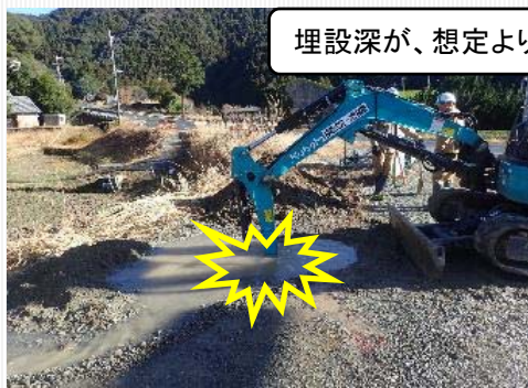
事故直後(水道管破損・漏水状況)
