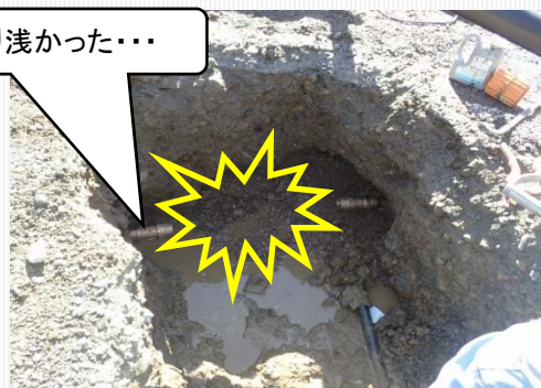
水道管破損・切断撤去
