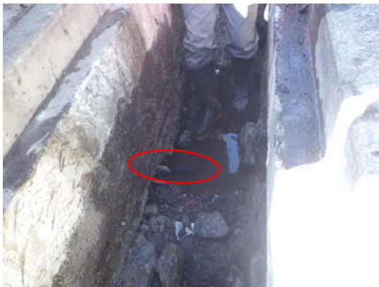
【当日の状況：0.10m 3 バックホウにより水道管（引込管）φ25mmを破損】
