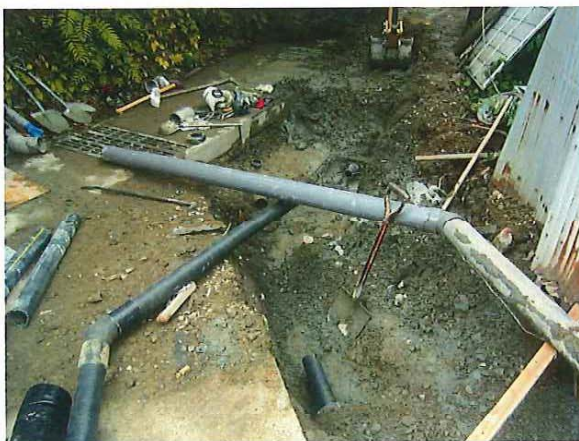
上流より下流を望む
