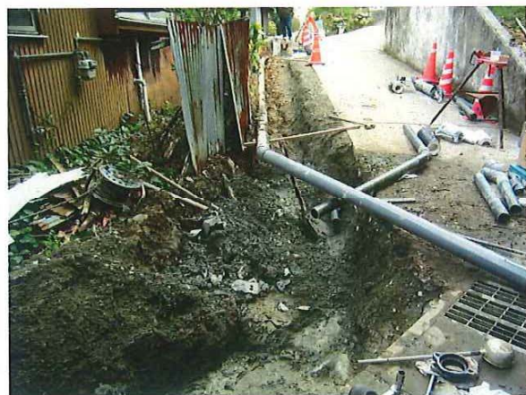
下流より上流を望む
