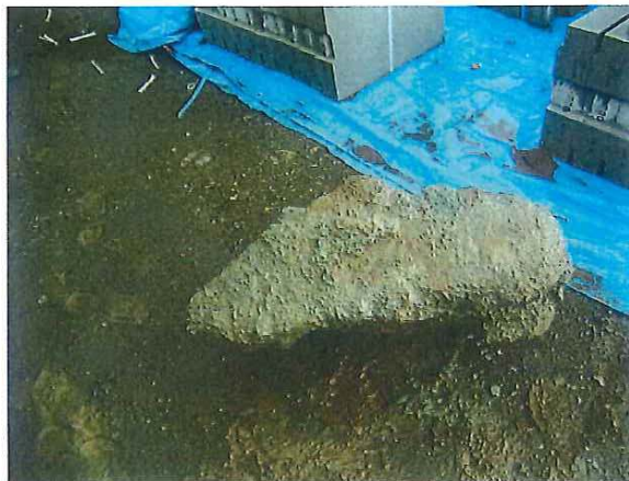
旧スラストブロック
