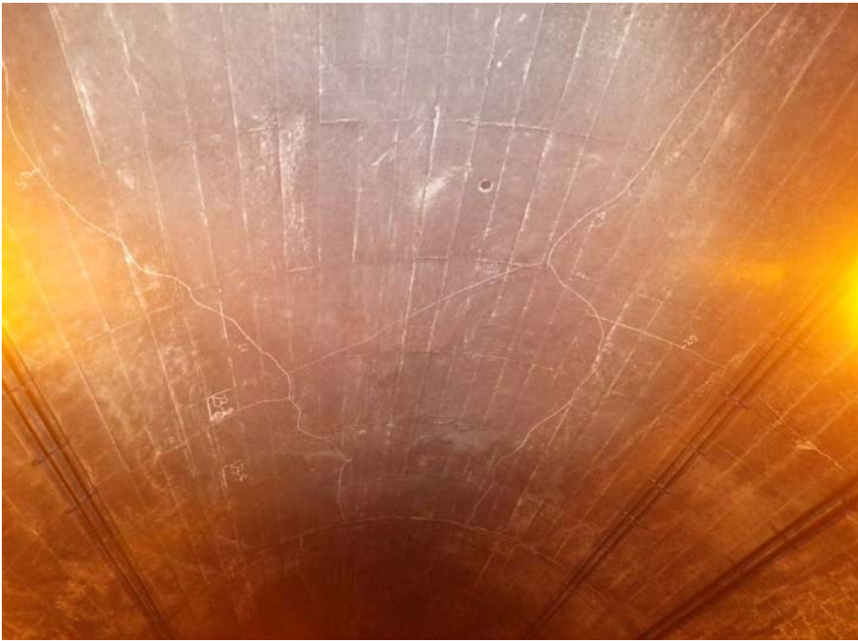
平成27年度 補修設計時の写真(漏出したと思われる既存注入孔)
