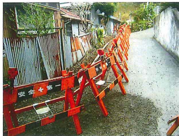
保安施設設置
