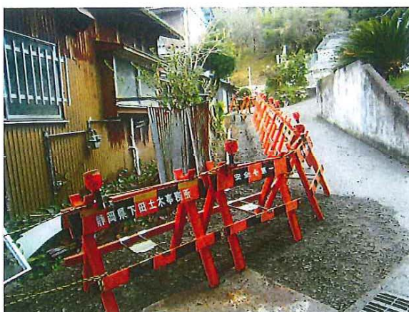
保安施設設置
