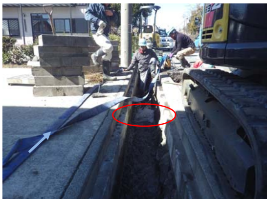
【当日の状況：0.10m 3 バックホウにより水道管（引込管）φ25mmを破損】
