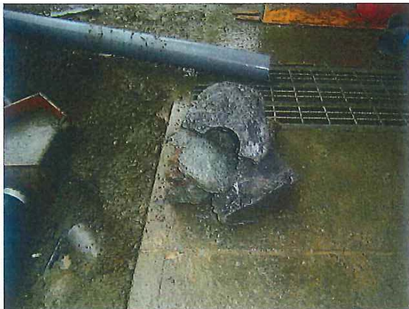
新設スラストブロック
