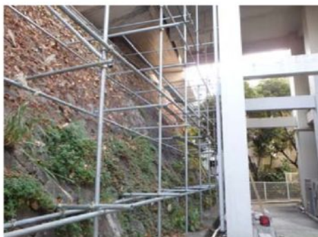
足場設置状況
