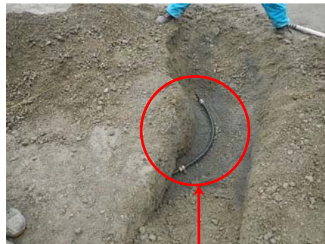
水道管復旧状況
