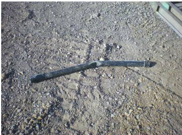
破損した水道管
