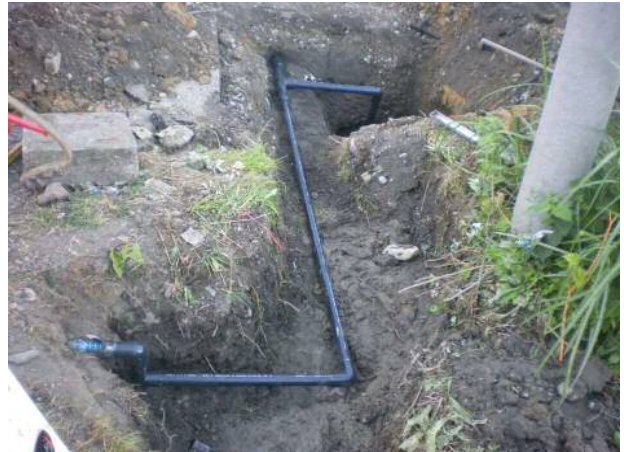
水道管復旧後
