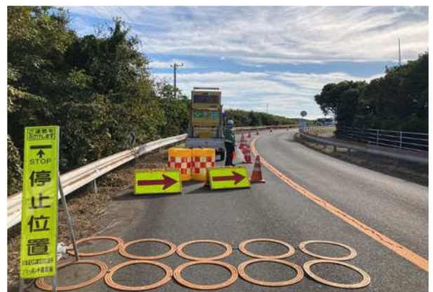
ジョイントリング(厚 1cm)の設置 →振動、音でドライバーに注意喚起
