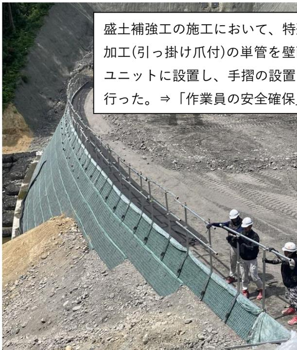
盛土補強工の施工において、特殊加工(引っ掛け爪付)の単管を壁面ユニットに設置し、手摺の設置を行った。⇒「作業員の安全確保」
