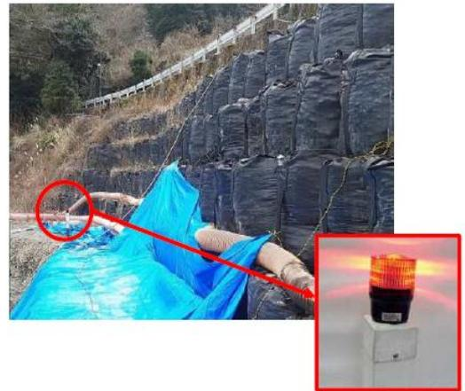
斜面の挙動を監視する「センサー杭」が、異常を検知し、斜面崩壊前にランプが点灯！ ⇒ 「作業員の安全確保」
