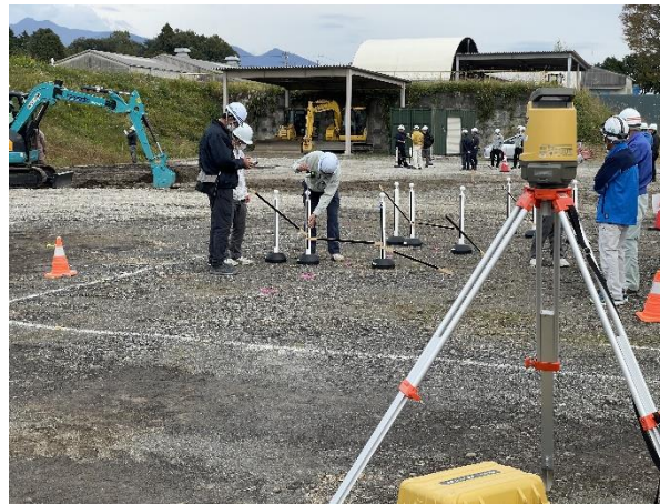
TSを用いた出来形管理
