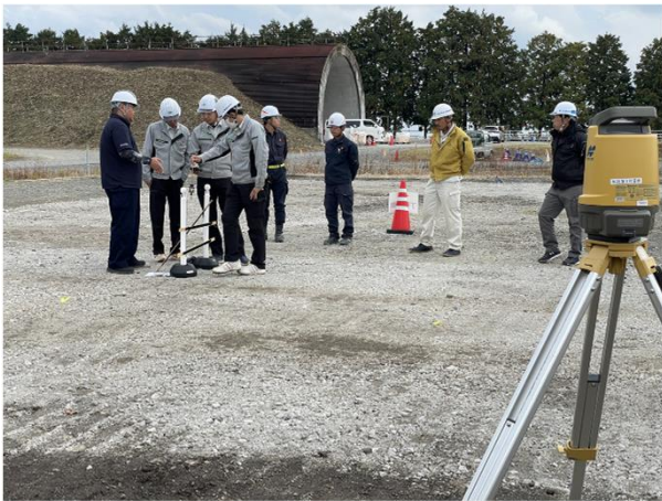
TSを用いた位置出しからの丁張
