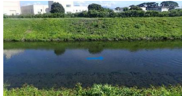
現地状況写真
