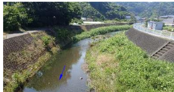
現地状況写真
