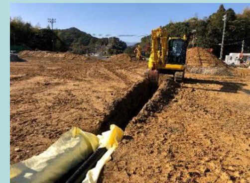
0.28m 3 級BH(幅狭バケット装着)
