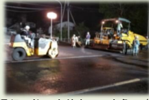
通行不能の交差点での応急工事
