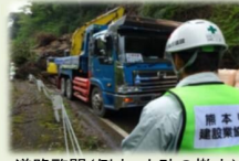
道路啓開(倒木・土砂の撤去)
