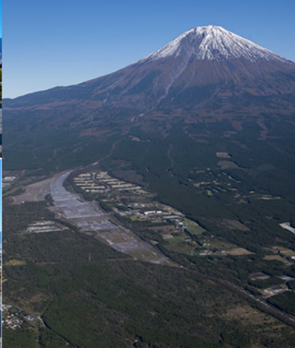
大沢川遊砂地工
