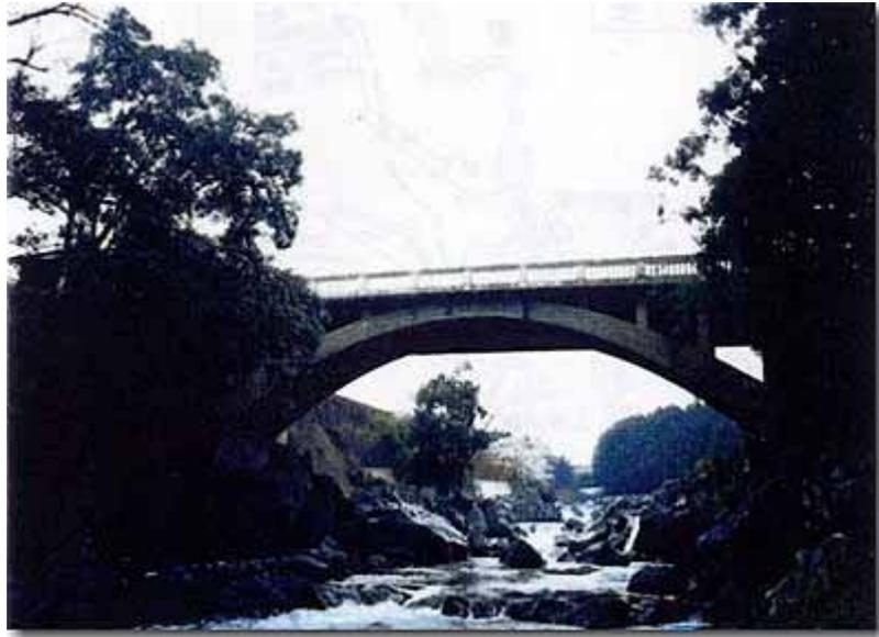
古くは現在よりも上流440m程のところに架橋されていたが、安政年間に流失し、その後かけ直しては流失を繰り返した。明治になって佳環地点を100mほど下流に移し、川幅が狭く、岩が迫っている地点を選んで架橋している。明治42年袖野往環道路の改築に合わせて、さらに下流の現地点に仮設したものである。構造形式はコンクリートアーチ橋である。
