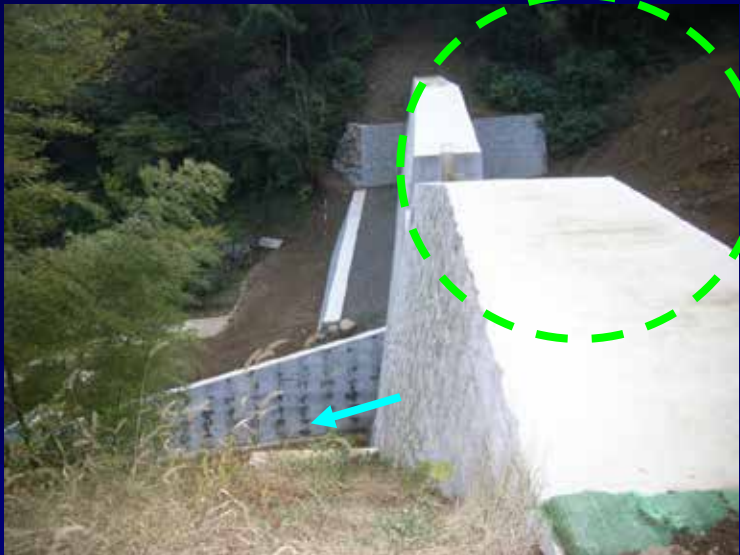
袖部施工直後
