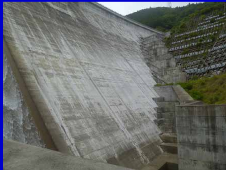
ダム下流面（H26.6.5撮影）
