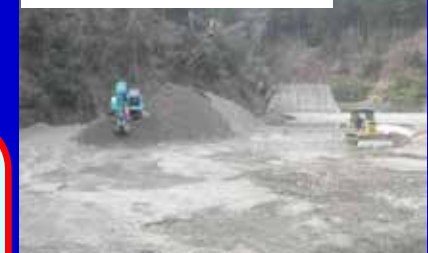
堆砂の掘削状況
