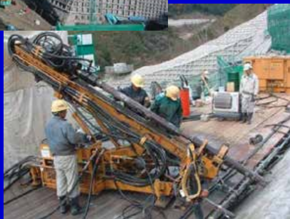
アンカー削孔状況
