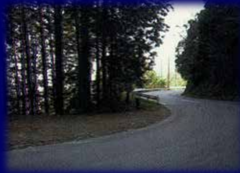
線形不良状況
