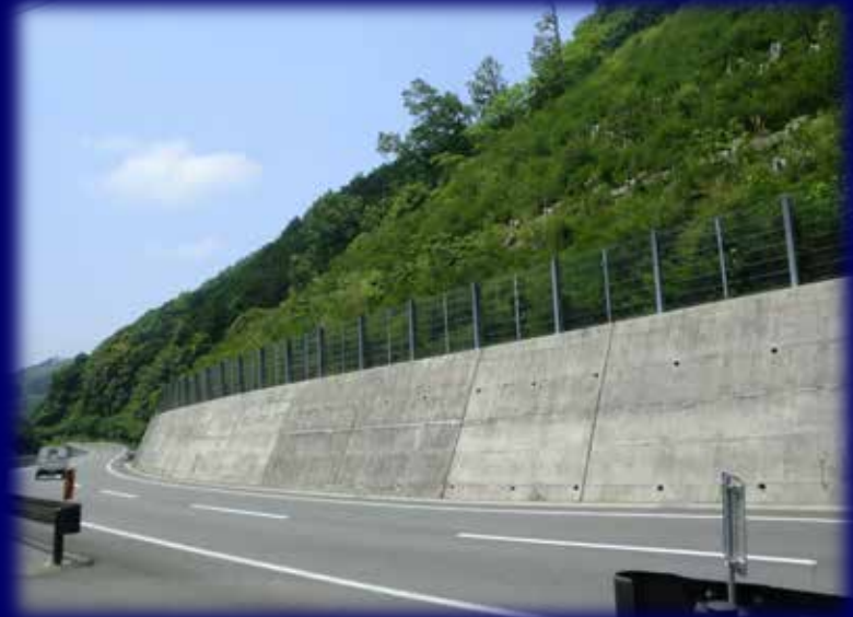
< 現在の法面緑化状況 >
