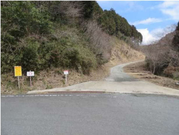
①起点の状況
