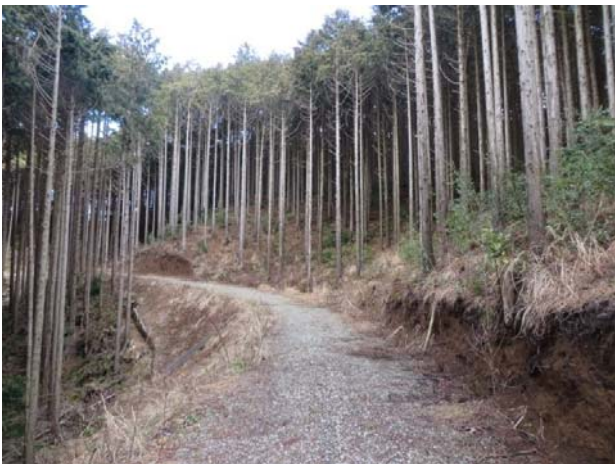
③受益区域内の作業道と間伐状況
