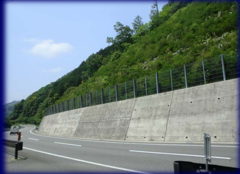
<現在の法面緑化状況>
