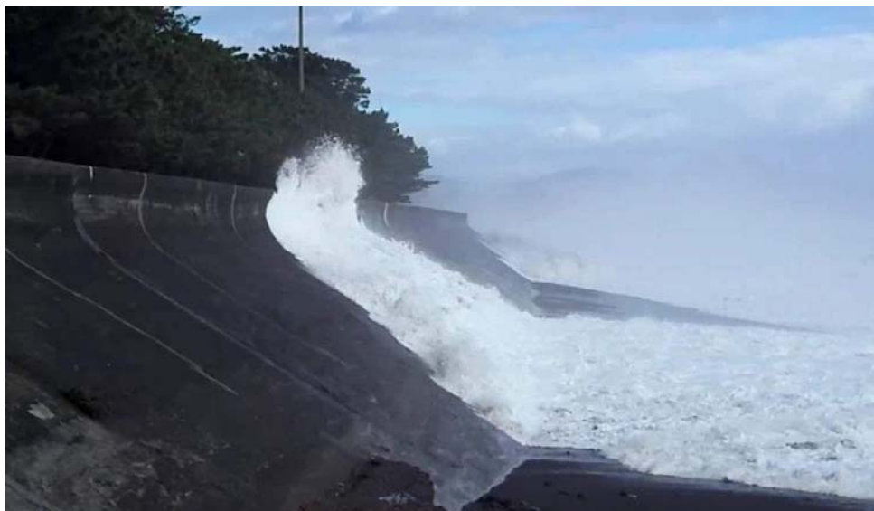
(越波・侵食状況・三保地区) 平成25年台風26号
