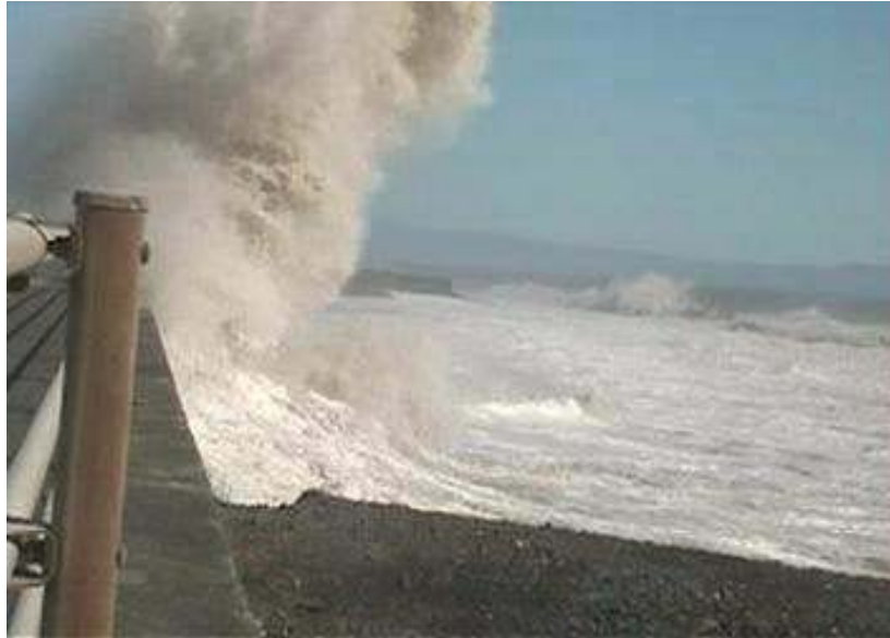
(越波・侵食状況・駒越地区) 平成16年爆弾低気圧
