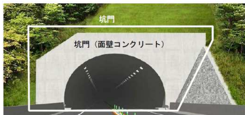
図 1.2 点検対象箇所（トンネル坑口部） 1)
