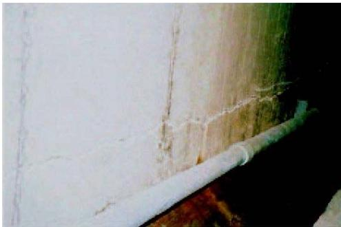
材料劣化のクラックとは異なり、柱（水門であれば堰柱、門柱）であれば柱幅のほぼ全幅にわたってクラックが発生する。擁壁であれば長尺のクラックが発生する。
