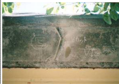
Vカット工
