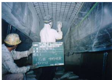
増厚（吹付け工）
