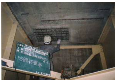
鉄筋防錆工
