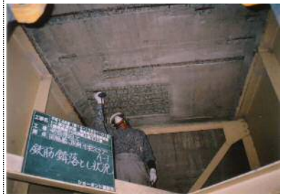
鉄筋錆落工
