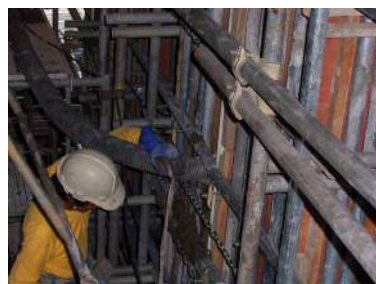
コンクリート打設工
