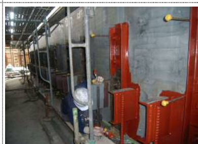
フーチングアンカー一定着工
