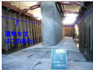
既設躯体状況
