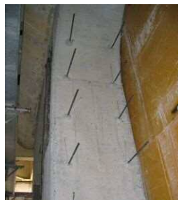
ずれ止めアンカー工
