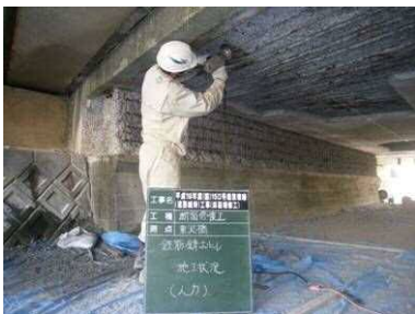
鉄筋錆落工
