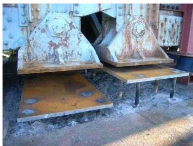
ベースプレート設置
