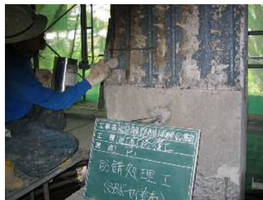
鉄筋防錆工
