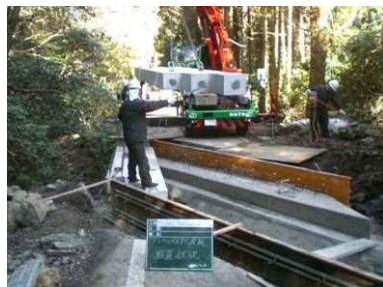
プレキャストPC床版設置工
