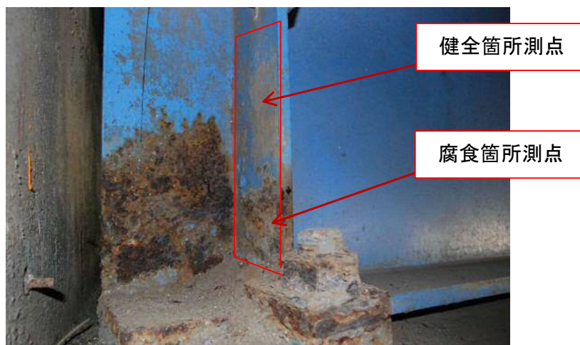
測定位置背面状況写真
