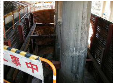
ライナープレート設置完了
