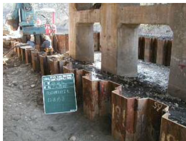
矢板打込み完了
