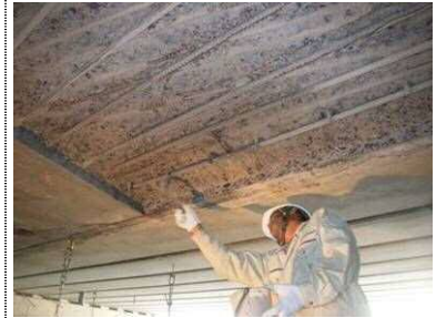
鉄筋防錆工
