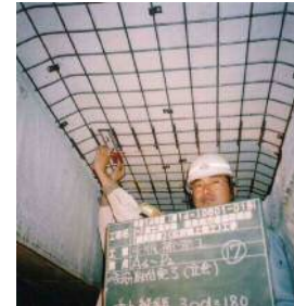
鉄筋取付工
