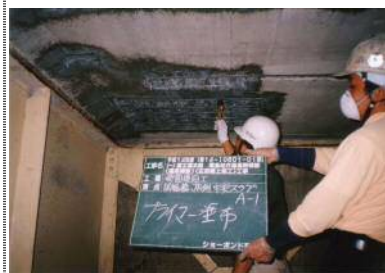
プライマー塗布工
