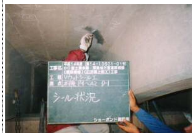
シーリング工
