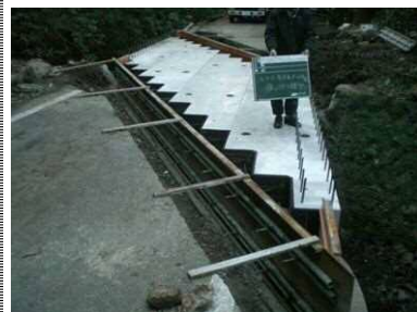
エラストイト貼付工
