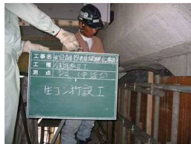
コンクリート打設工
