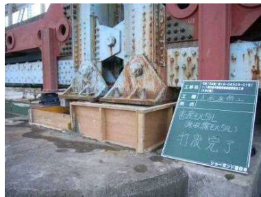
モルタル打設工
