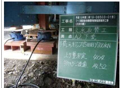
ジャッキアップ
