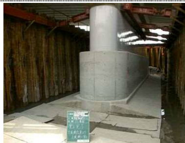
根巻きコンクリート工
