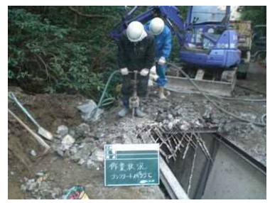
コンクリートはつり工
