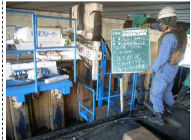
鋼矢板圧入状況
