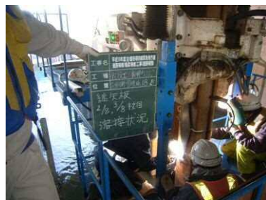
鋼矢板溶接状況
