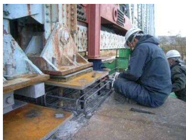
鉄筋組立て工
