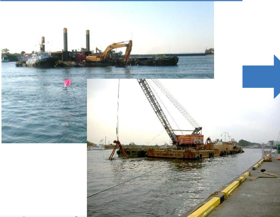
泊地・航路の浚渫
