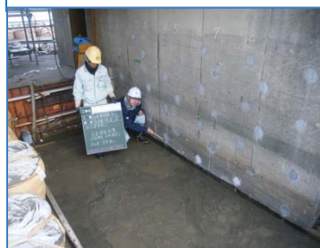
堰柱のせん断補強
