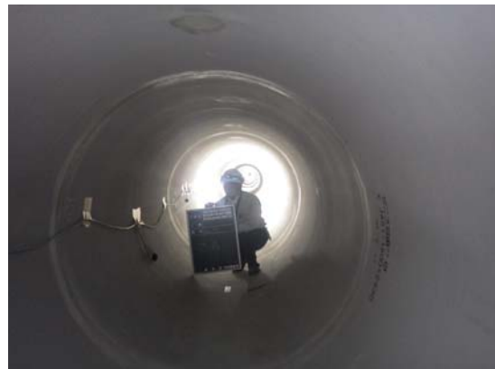
仕上がり状況
