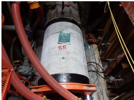
施工状況（推進管布設）
