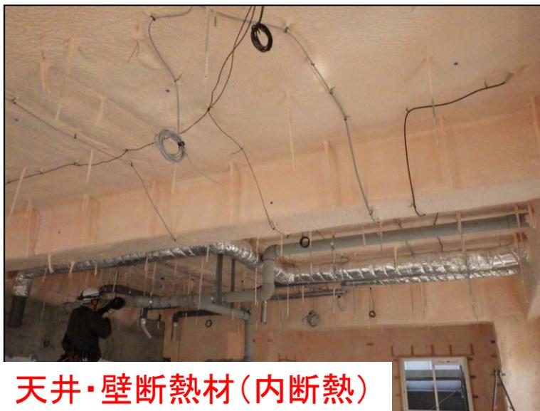
天井・壁断熱材(内断熱)
