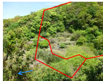
整備対象地(本堤工)
