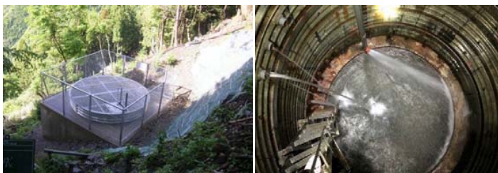
○集水ボーリング工の集水状況
