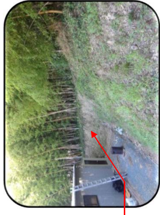
重力式擁壁工 (H=2.0m)
