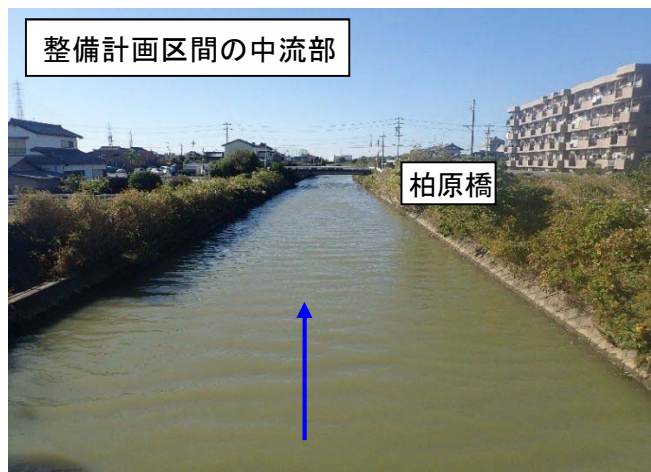
田端橋(0.9k付近)から下流を望む
