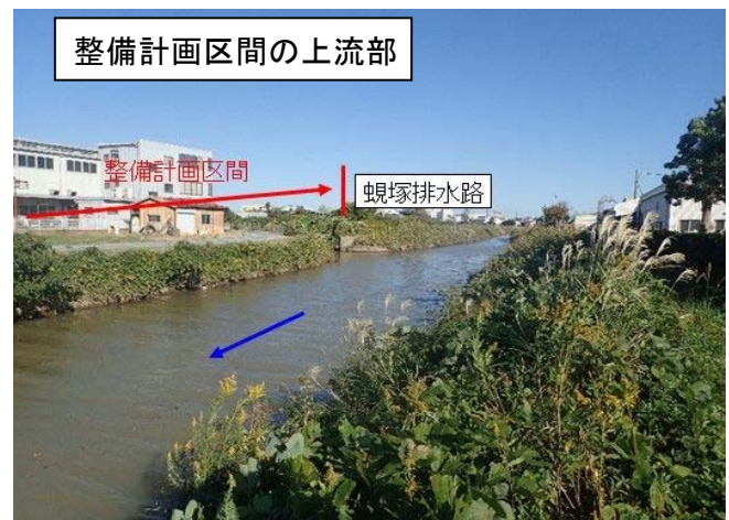
蜷塚排水路(2.3k)付近から上流を望む
