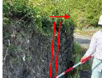
擁壁の末端押し出し(F2)
