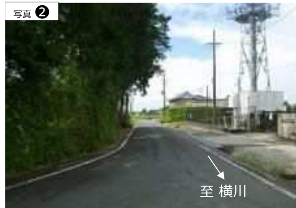
幅員が狭小な区間
