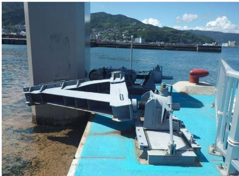
H28.8の台風9号による係留装置の損傷状況
