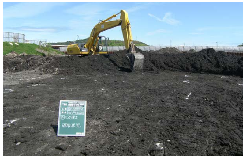
固化処理土除去
