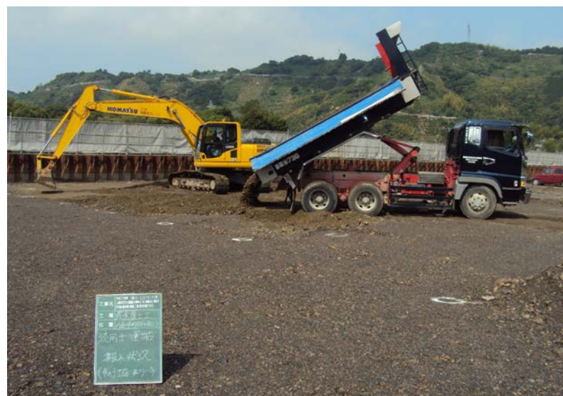
環境覆土施工
