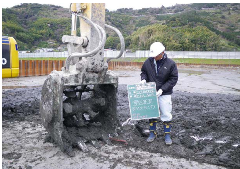
固化処理工施工
