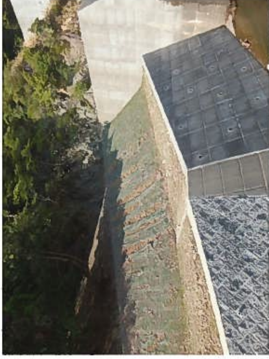
植生シート施工部の現状況
