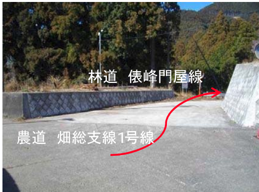
① 林道俵峰門屋線起点
