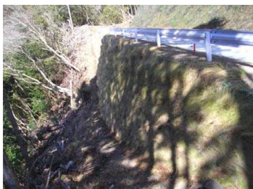
⑩ コスト縮減(補強土壁工)
