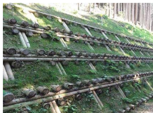
⑪ 工事における木材利用 (パネル式簡易丸太枠)
