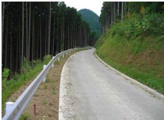
③ 開設した林道の状況
