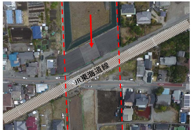
JR東海道線交差部付近
