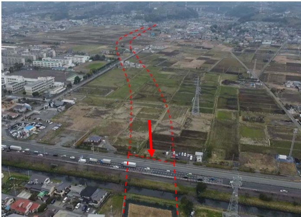
国道1号から上流方向
