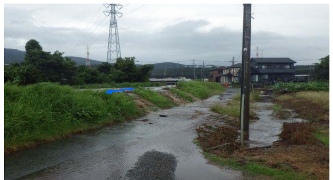
(H26.10 台風18号: 高橋川越水状況)
