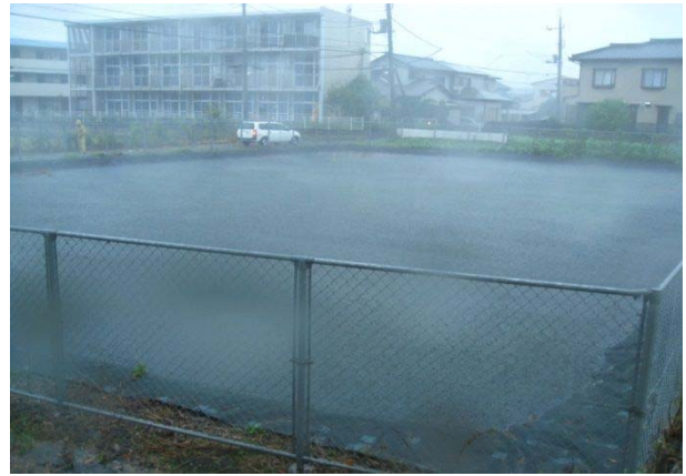
暫定調整池(H26.10湛水状況)
