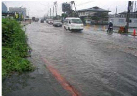
①H15.7洪水浸水状況(伝法沢川右岸)
