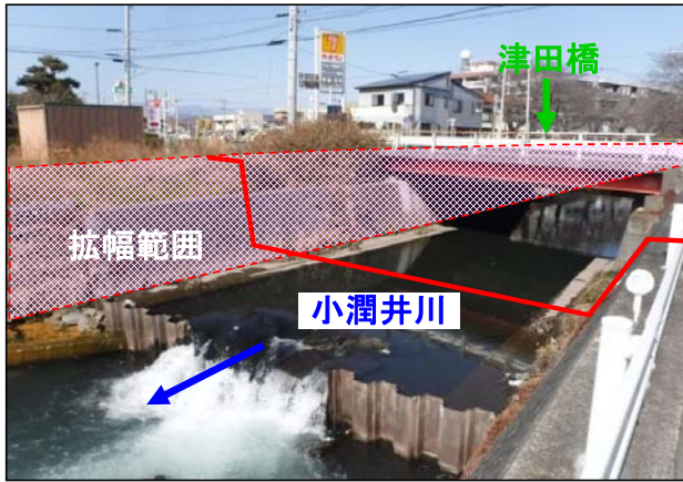
河道改修区間(津田橋周辺)
