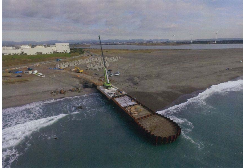
(突堤工施工箇所)
