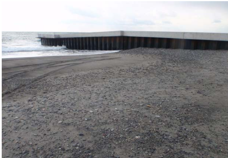
(突堤工施工箇所)
