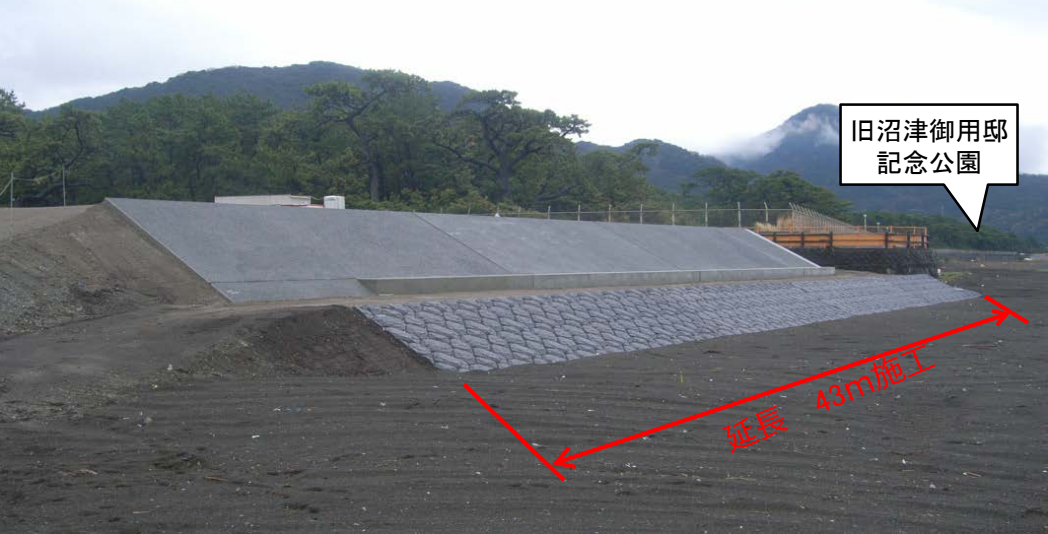
海岸堤防の整備（H29施工区間）
