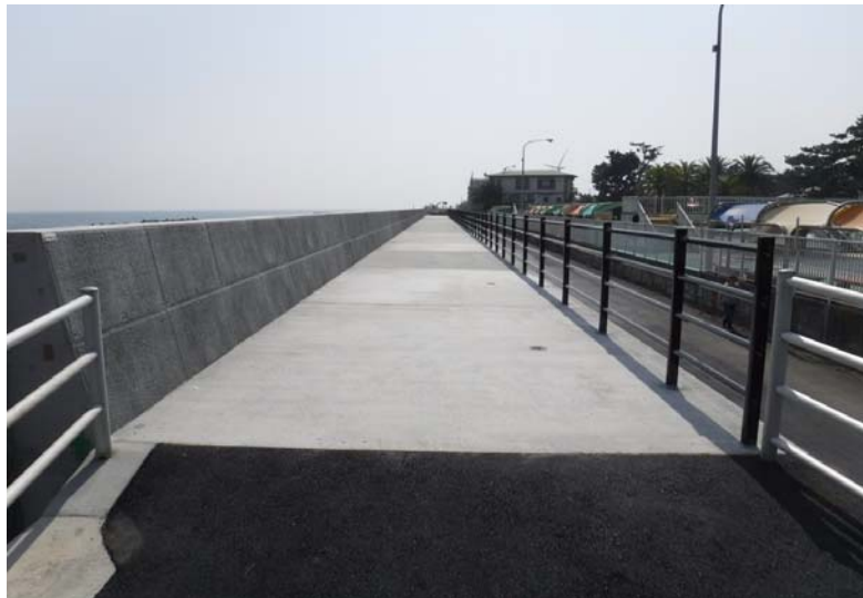
(堤防嵩上完了箇所)
