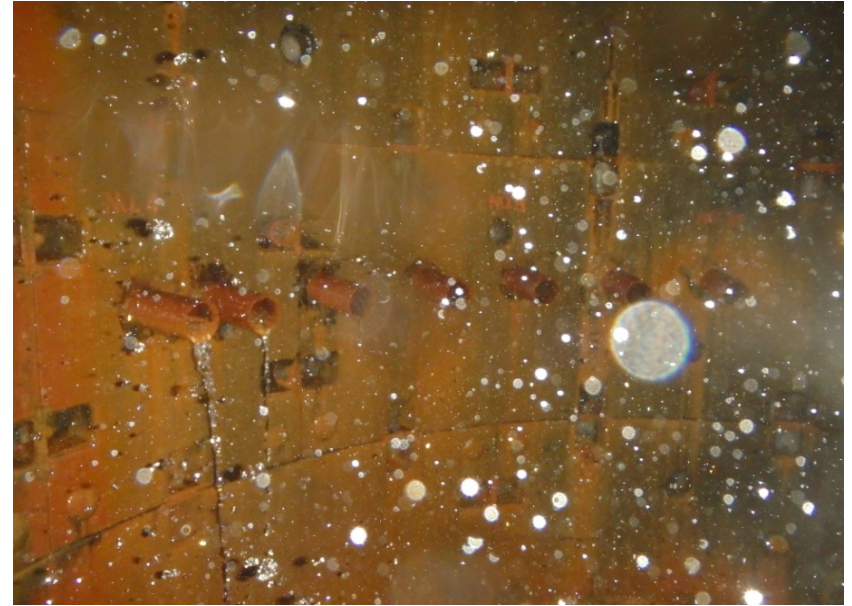
下段集水ボーリング排水状況(W-18集水井(H27施工))
