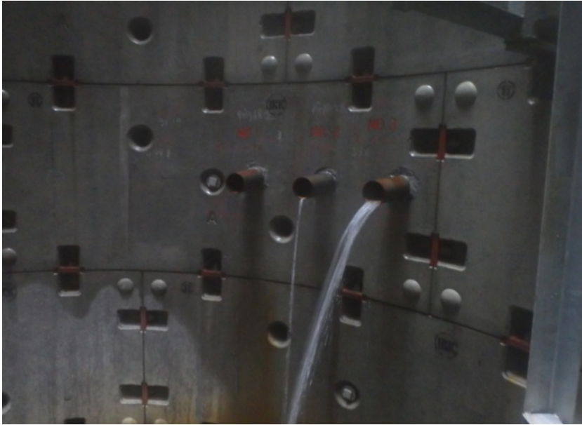
上段集水ボーリング排水状況(W-18集水井(H27施工))
